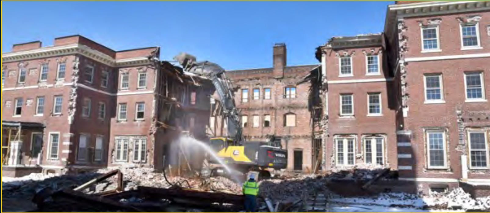
YWCA Demolition - April 5, 2016
