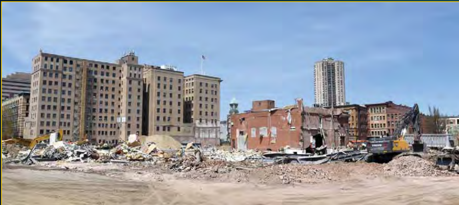
YWCA Demolition - April 21, 2016
