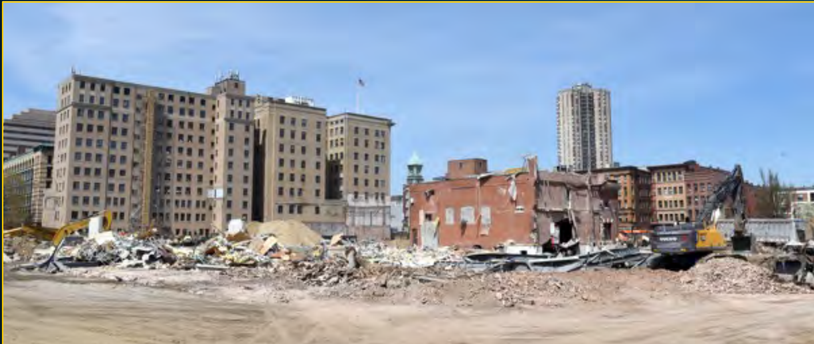
YWCA Demolition - April 21, 2016
