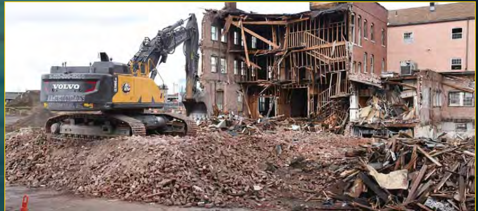
YWCA Demolition - April 8, 2016
