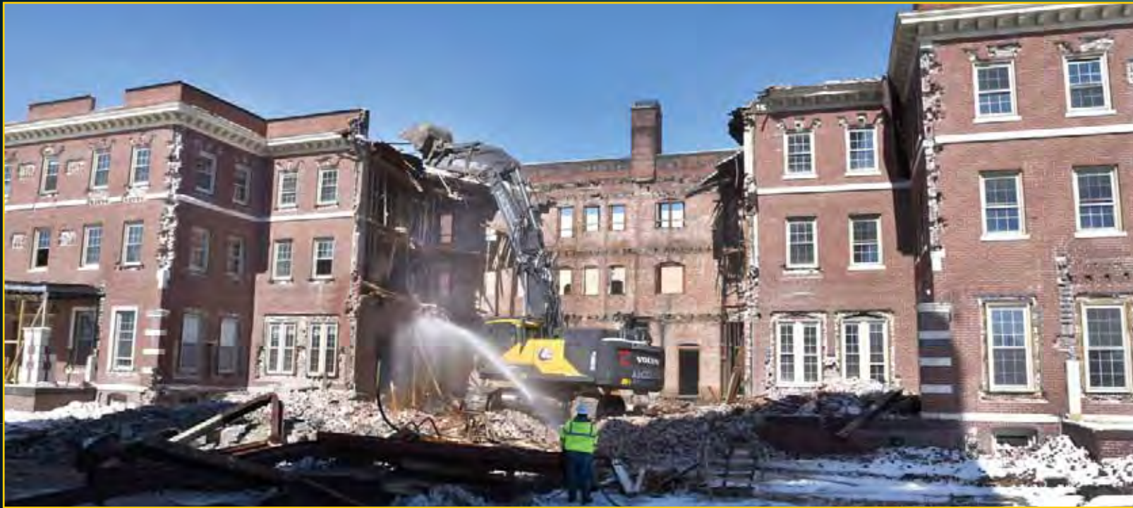
YWCA Demolition - April 5, 2016
